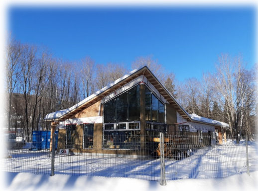
Pavillon d'accueil au parc de la plage en date du 6 février 2024
